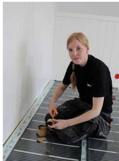
Flexwatt varmemefolie er en ideell løsning for parkett, laminat eller tregulv. Montør Ann Kamilla Bentzen bruker ekstremt kort tid på å legge folien i huset på Nedre Steinsåsen som er på 160-170 kvm.
